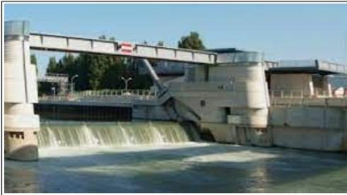
**Les barrages de navigation permettent le transport fluvial tout en régulant le niveau d'eau des fleuves et des rivières.**
