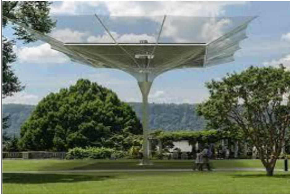
La star-up SoftGreen étudie un nouveau système (le Water Sun Canopy) permettant de fournir de l'eau de pluie consommable et de l'électricité produite par un capteur solaire.
